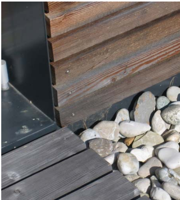
Abbildung: Verschleißleisten im Spritzwasserbereich. Wohnhausanlage Winklarn. Foto: Manuel Schweizer
