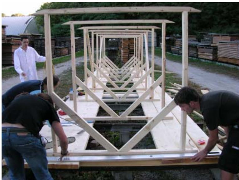
Abb 67 - Aufbauarbeiten der Fassadenelemente - Grundkonstruktion an der HTBLuVA Mödling
