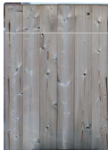
Abb 128 & 129 - Auswirkungen des Spritzwassers auf den direkt bewitterten Fassadenbereich (oben) und die unterschiedliche Vergrauung im Traufenbereich (unten)
