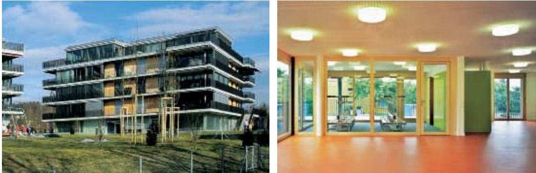
Abbildung 1.9 Siedlung Steinacker in Zürich (Fotos tec 21)
