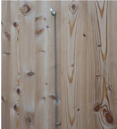
Abbildung: Stahlhaken verzinkt in unbehandelter Lärchenfassade. Foto: Roman Smutny
