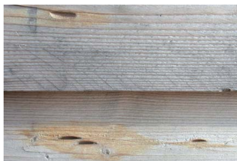
Abb 125 & 126 – „Fleckenbildung“ auf Grund von Holzgallen (li) und weiter Gründe für unregelmäßige Vergrauung der Holzoberfläche (re)
