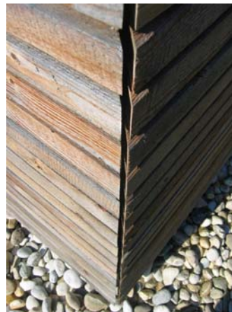
Abbildung: Vertikalfuge und Eckfuge, je 1 cm. Wohnhausanlage Winklarn. Foto: Ulla Ertl
