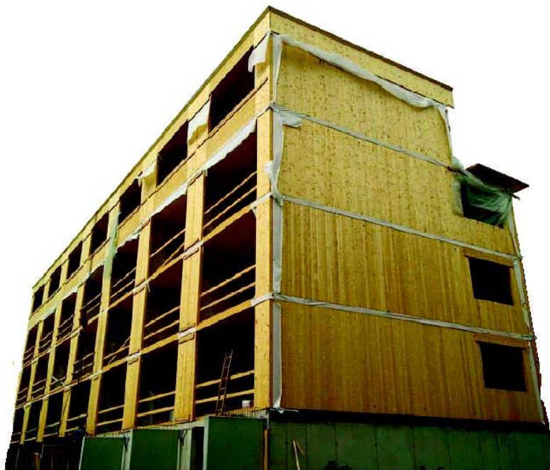
Abbildung: WHA Spöttlgasse im Rohbau (Quelle: HdZ-Bericht 34/2001)
