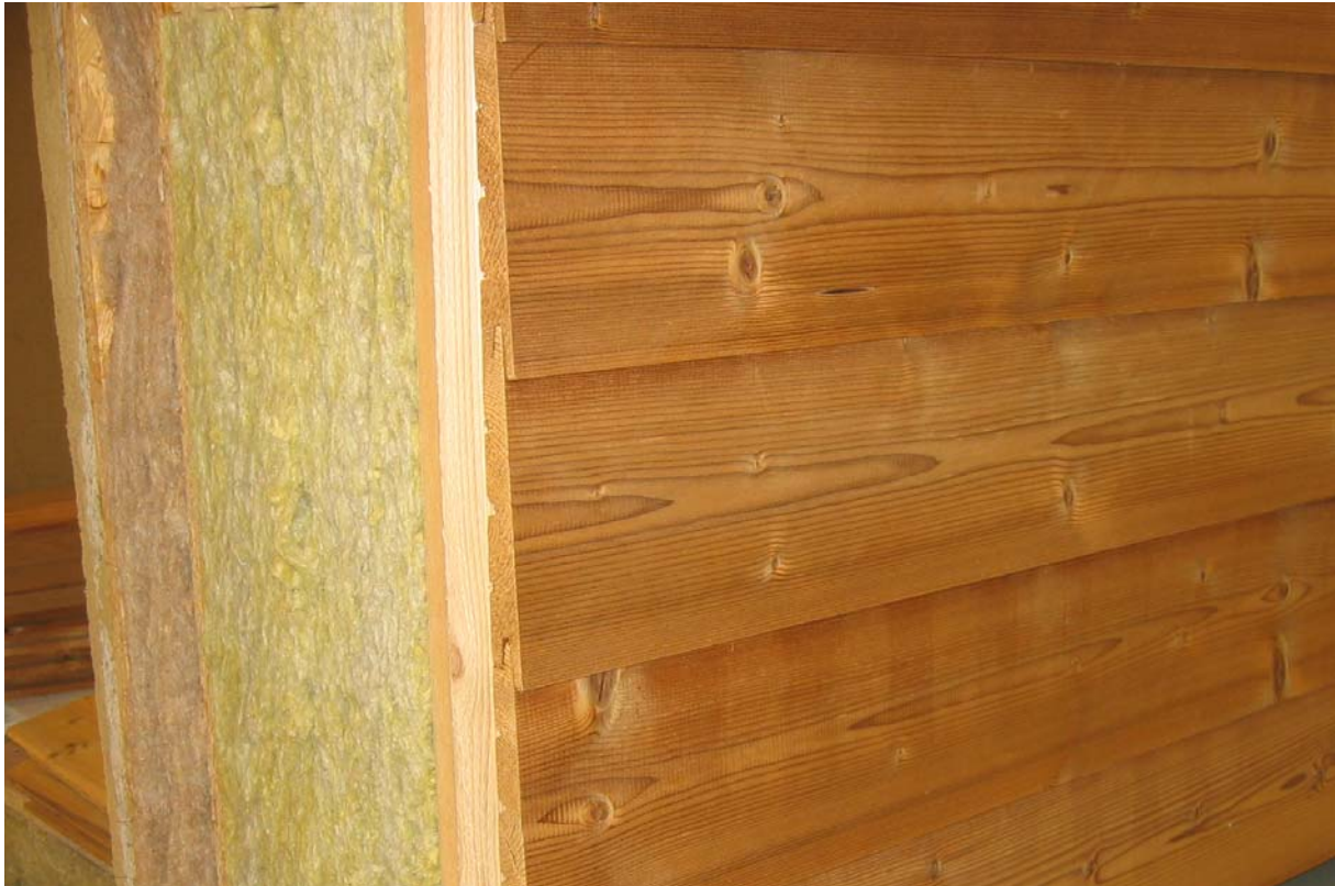
Abbildung: Wandaufbau mit Schuppenschalung aus ThermoWood-Fichte (Foto: Ulla Ertl)
