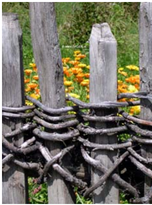
Abb 2 - Befestigung der Zaunlatten mittels hitzebehandelter Zweige
