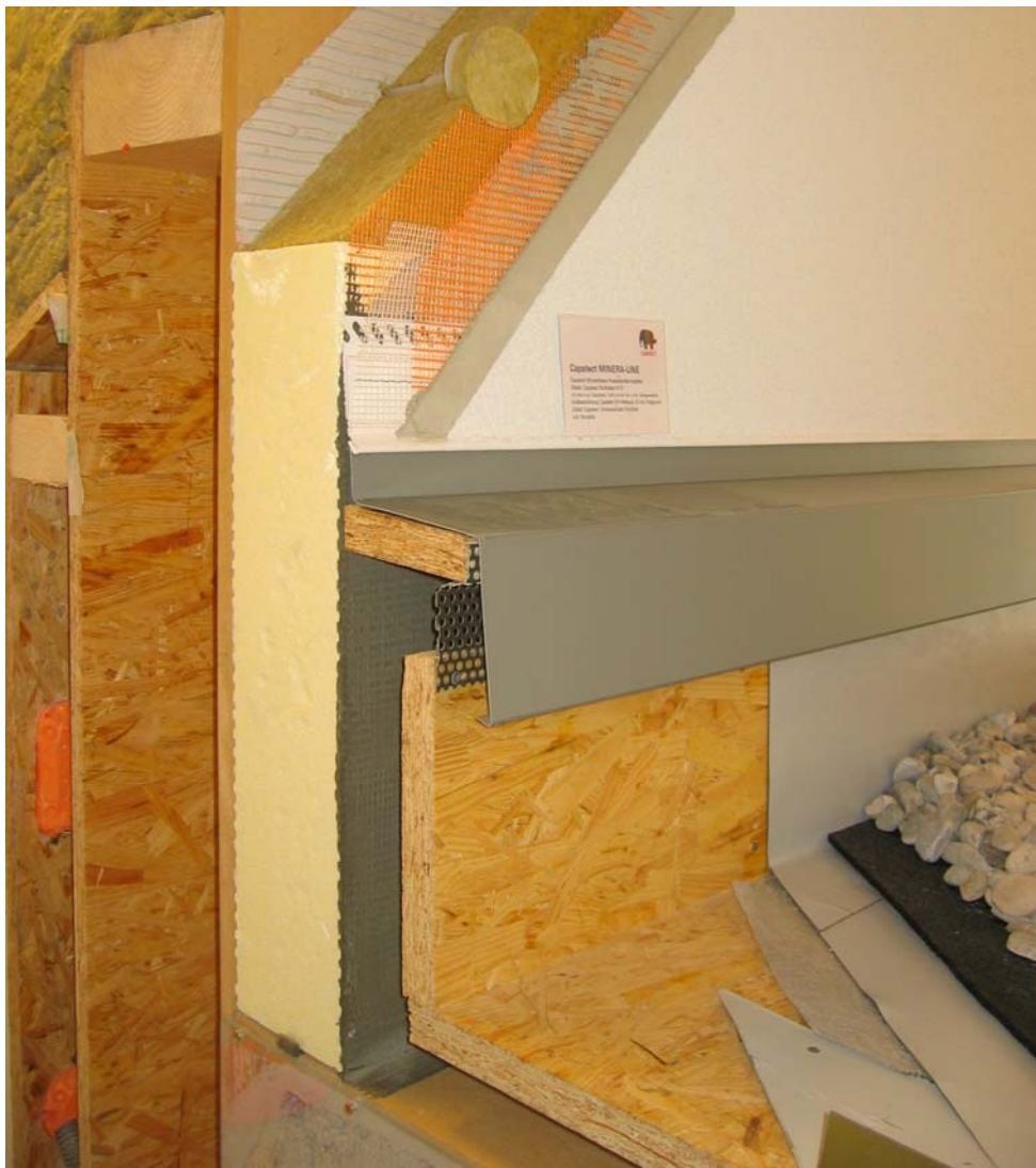
Abbildung: Anschluss Wand-Flachdach (Foto: Ulla Ertl)
