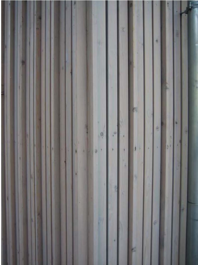
Abbildung.1 Leistenschalung mit grau pigmentierter Lasur (Foto M. Schweizer, 2006)
