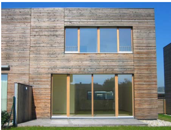
Abbildung: Vertikalfuge und Eckfuge, je 1 cm. Wohnhausanlage Winklarn. Foto: Ulla Ertl
