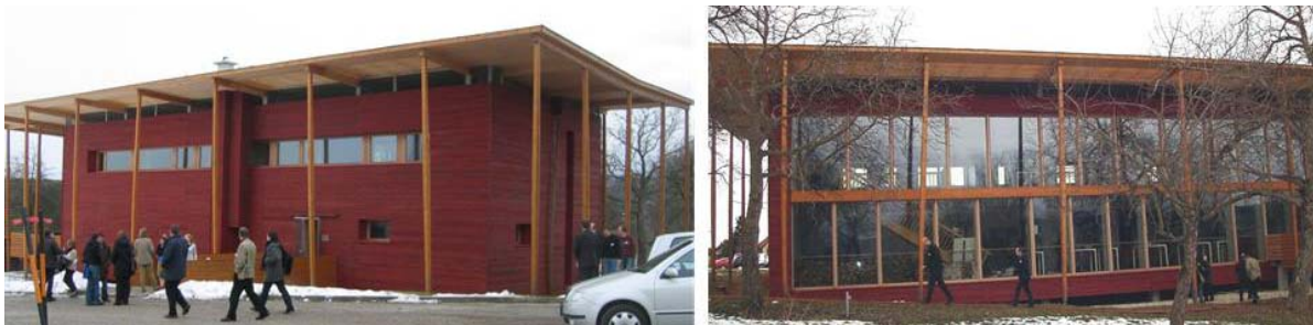
Abbildung: S-House (Sustainable-House), Böheimkirchen (Quelle: HdZ-Berichte 2/2005, 12/2006)
