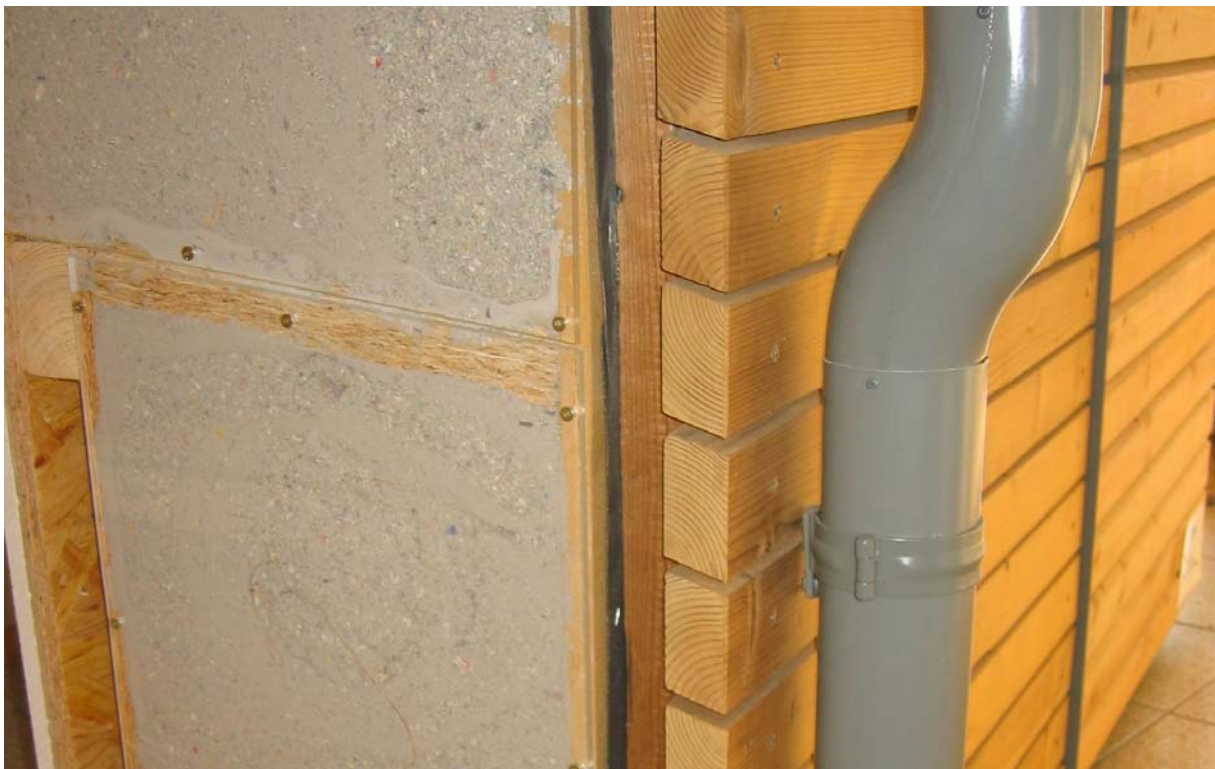
Abbildung: Wandaufbau mit Zellulosedämmung und horizontaler, abgeschrägter Leisten-schalung (Foto: Ulla Ertl)
