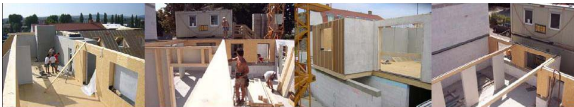
Abbildung: Baustellenfortschritt (Quelle: Arch. W. Hackermüller)
