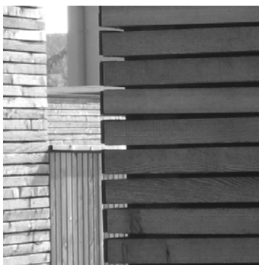
„Weiche Ecke“ der offenen Fugen in der Leistenschalung
