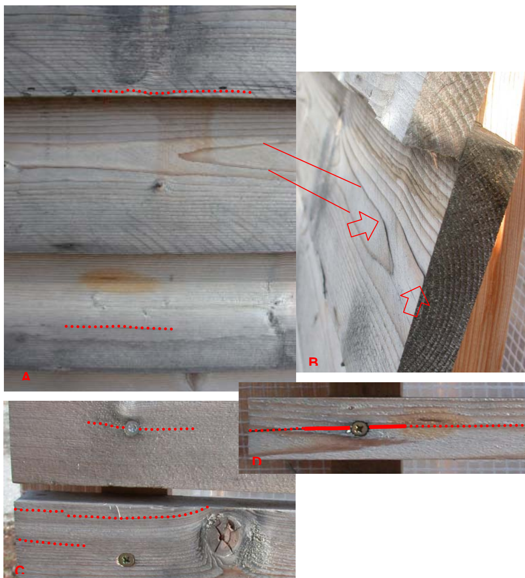
Abb 123 – Rissbildung (A, C, D) oder Ablösen von Fladerschichten (B) an thermisch modifiziertem Holz nach 12 Monaten Bewitterung
