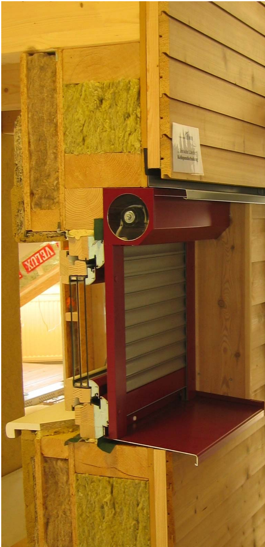
Abbildung: Wandaufbau mit Fensteranschluss. Unten: Schuppenschlaung, oben: Keilspund-schalung (Foto: Ulla Ertl)
