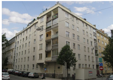
ZUSTAND VOR DER SANIERUNG
