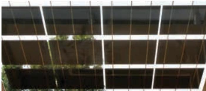
Abbildung 3: PV-Glas-Glas-Module
